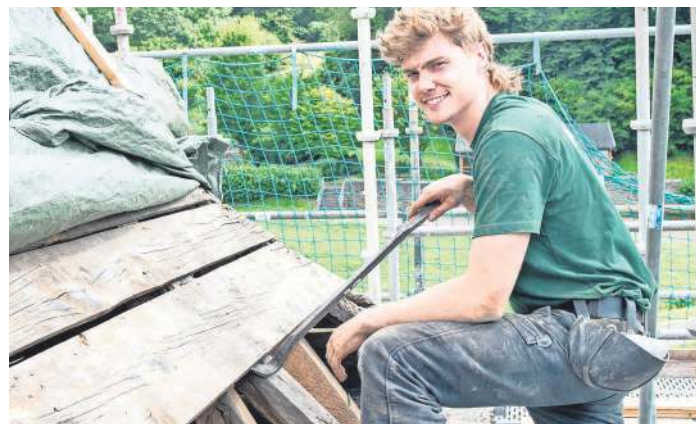
Moriz Schönfeld auf dem Dach der alten Kirche in Oberweidbach. Die Verschalung wird gelöst, um das Fachwerk zu sanieren.
