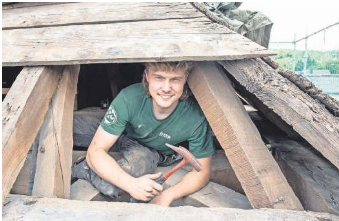
Sanierungsarbeiten am Holzaufbau der alten Kirche.
